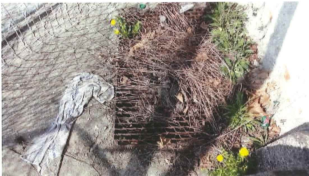
Zdj. nr 11 Studzienka kanalizacyjna z ażurową kratą, przy ścianie hali.
