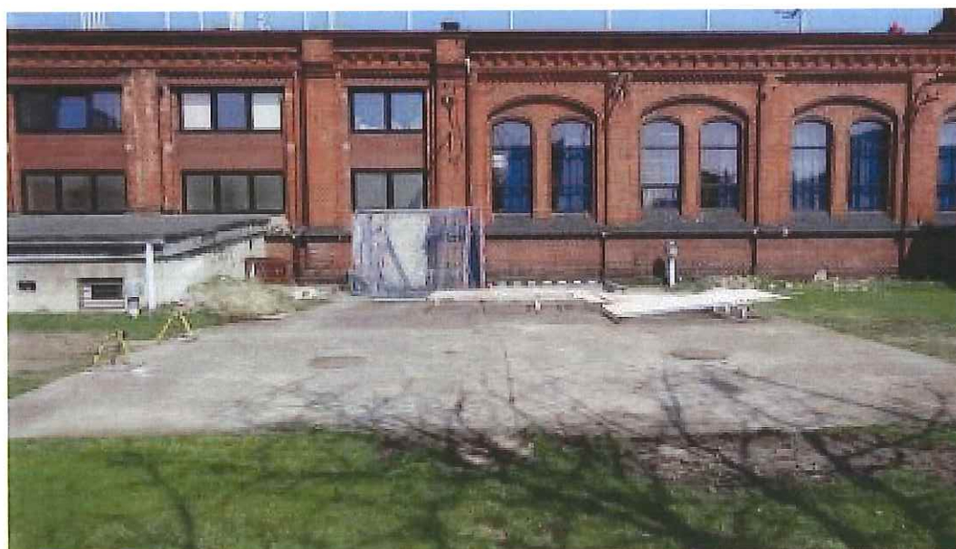
Zdj. nr 8 Widok stropu nad magazynem opału. Od góry wykonano 9-10 cm płytę z betonu chroniącego izolację z papy bitumicznej. W stropie zabetonowano 4 włązy żeliwne do zasypywania magazynu węglem.
