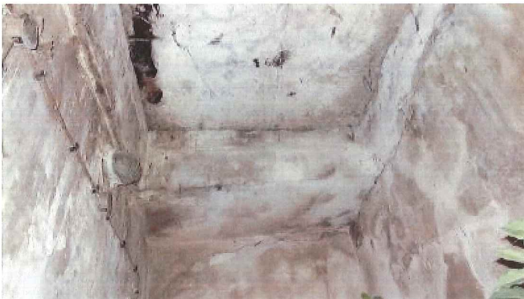
Zdj. nr 25 Zabetonowany szyb windy przy klatce schodowej prowadzącej na dziedziniec hali. Szyb windy ma prowizoryczną izolację ma warstwę wykładziny podłogowej PCV.
