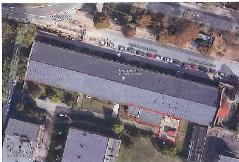
Zdj. Nr 1 Piwnice przy Hali Sportowo Rekreacyjnej. Zakres objęty opracowaniem – czerwona obwódka.
